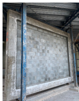
Parede pronta para ensaio
