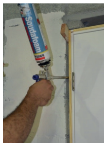
Aplicação da espuma expansiva multiuso
