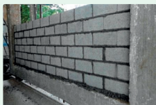
Parede em construção
