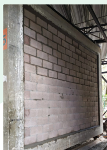
Montagem da parede
