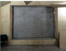
Montagem da parede
