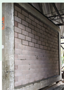
Montagem da parede
