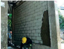
Montagem da parede
