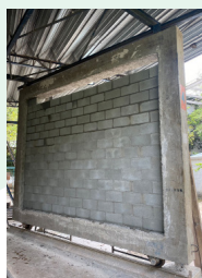
Montagem da parede
