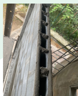
Montagem da parede
