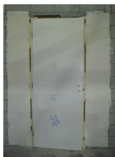
Porta fixada na alvenaria
