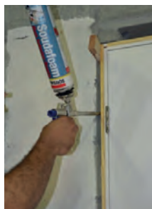
Aplicação da espuma expansiva multiuso
