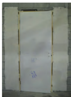
Porta fixada na alvenaria
